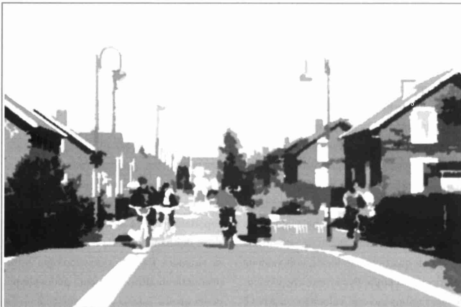
Figura 1. Esempio di "porta di accesso", con restringimento della carreggiata, ad una zona residenziale
